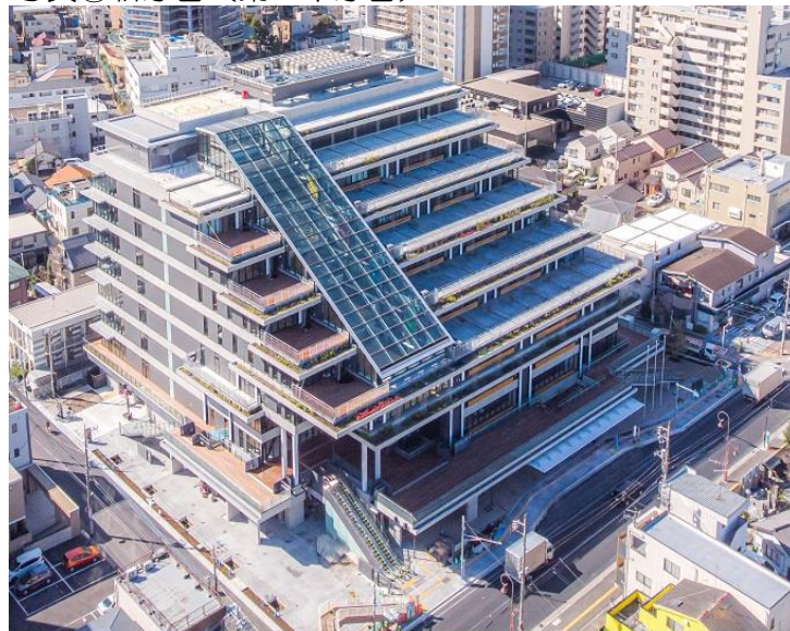
写真①新庁舎（第一本庁舎）
