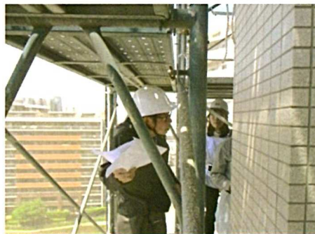
修繕委員会による足場からの確認
